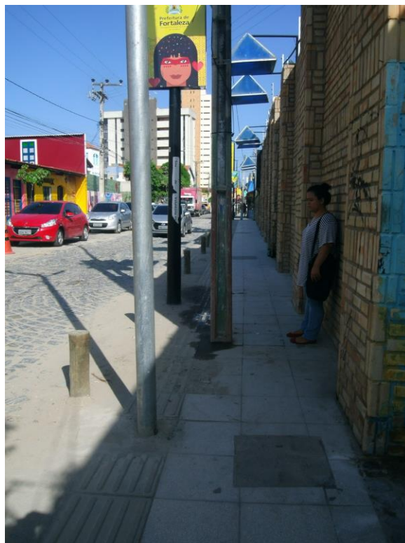
Figura 05: Postes como obstáculo na calçada
